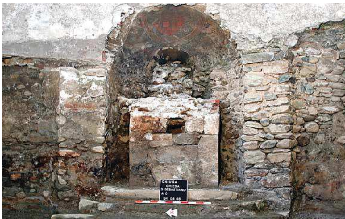
Fig. 13. L'abside della chiesa inferiore (foto degli Autori).
