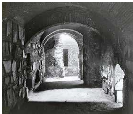
Fig. 1. Roma, Catacomba di S. Valentino, una galleria prima del crollo del 1986 (Archivio Pont. Istituto di Archeologia Cristiana).
